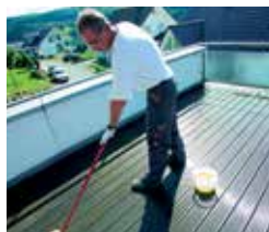
2. Pokud je to nutné, očistěte terasu Ostraňovačem šedi dřeva
