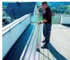
3. Natírejte ve dvou vrstvách Udržovací olej na WPC
