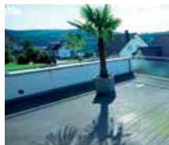
1. Terasa v původním stavu
